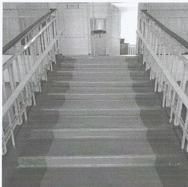
Лестница со второго этажа (фото №4)
