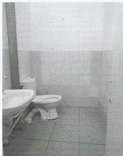
Туалет на первом этаже(фото №6)
