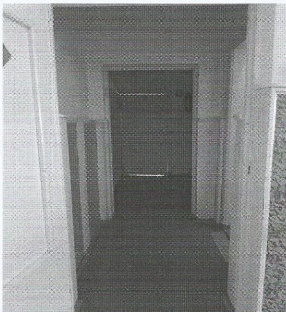
Коридоры в здании(фото №11)
